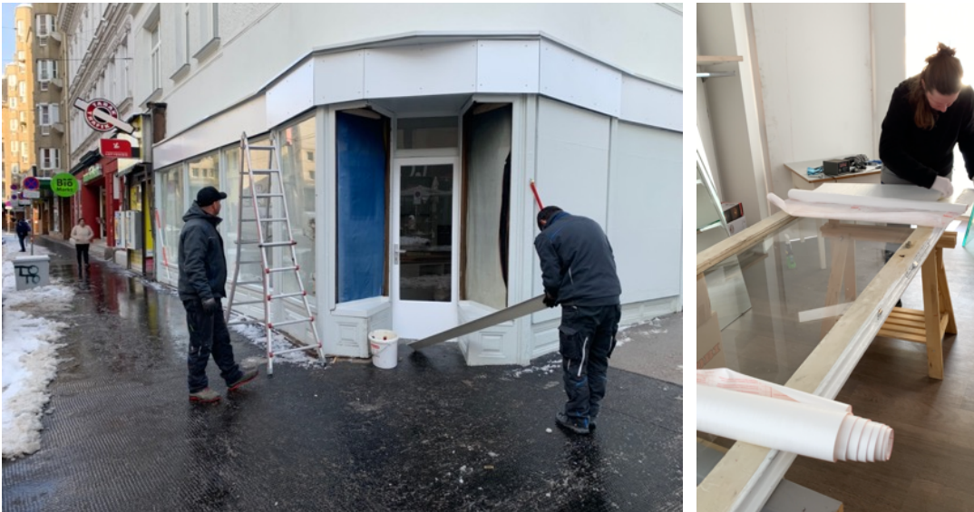
Erneuerung des Geschäftsportals bei unserer neuen Zentrale Anfang Dezember 2023
